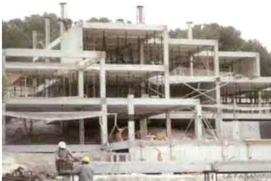
Hiện trường thi công kỹ thuật công trình bê tông dự ứng lực chế sẵn của một siêu thị tại Marseille
